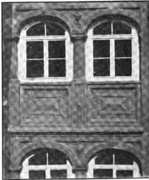
Abb. 48. Haus A 8. Loggia.
