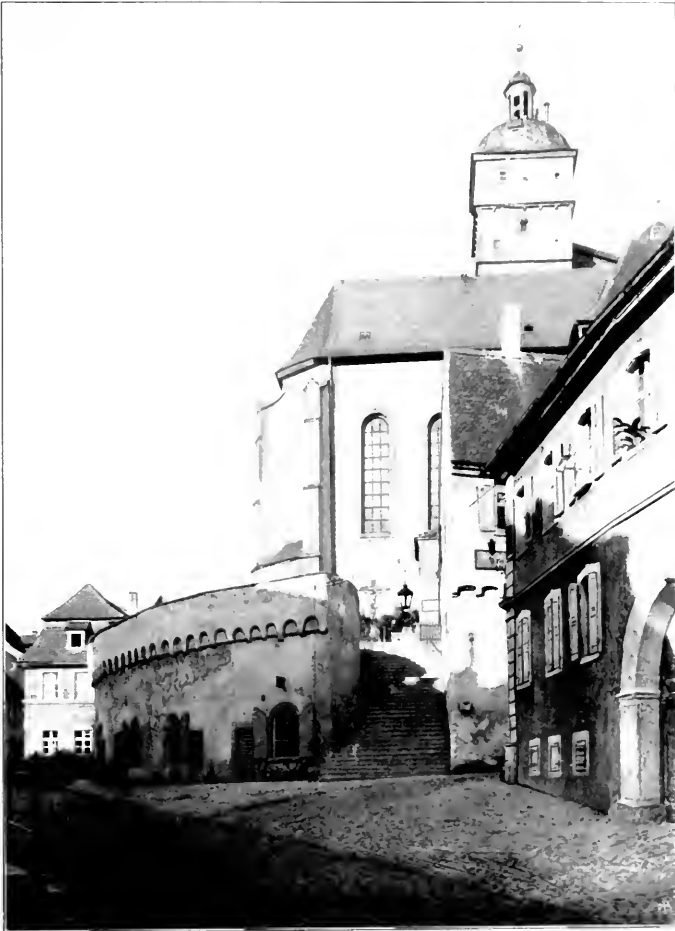
STADTPFARRKIRCHE ZU DETTELBACH. ERWEITERUNGSBAU IM WESTEN. VGL. GRUNDRISS S. 211 OBEN UND GESAMTANSICHT S. 213. — Text S. 208
