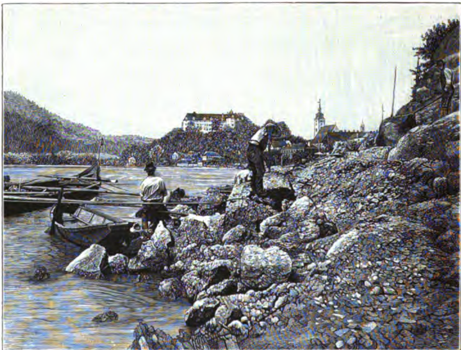
Regulirungsarbeiten am Greiner Schwall (1894). (Nach einer Photographie des Verfassers.)
