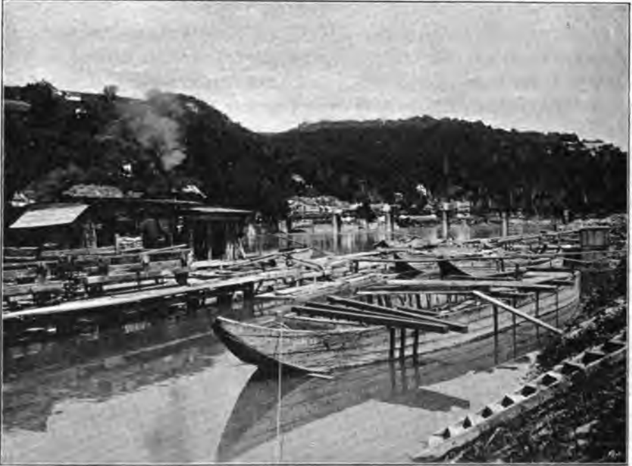
Quaibauten in Passau. (Nach einer Photographie des Verfassers.)
