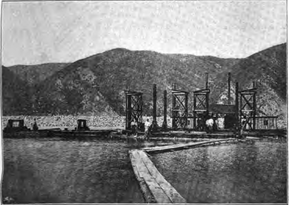
Bohrloß zur Regulirung der Stromhindernisse in der Kataraktenstrecke.
