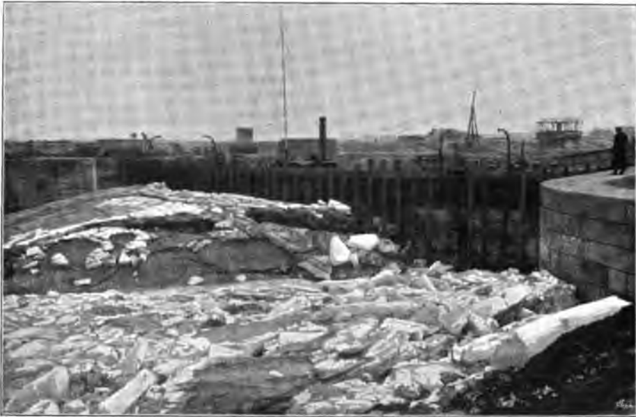
Siebbarre vor dem Sperrschiff am 16. Februar 1893. (Nach einer photographischen Aufnahme von Ingenieur Ferd. Hartwich.)
