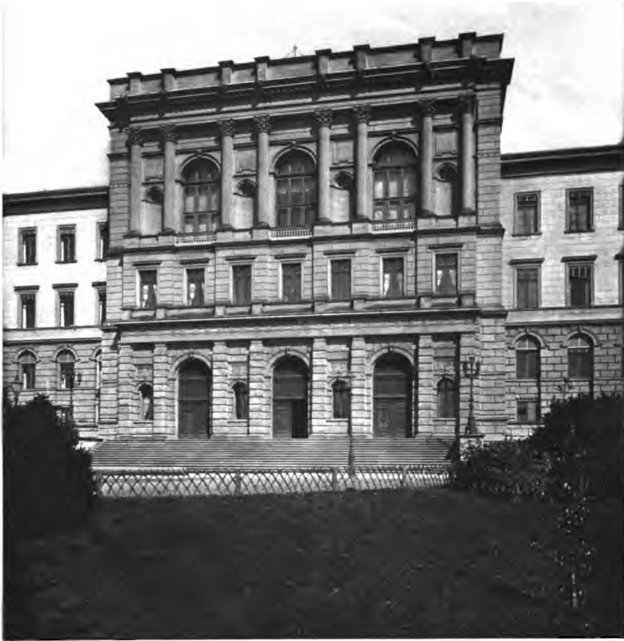
HAUPTGEBÄUDE DER ETH ZÜRICH
