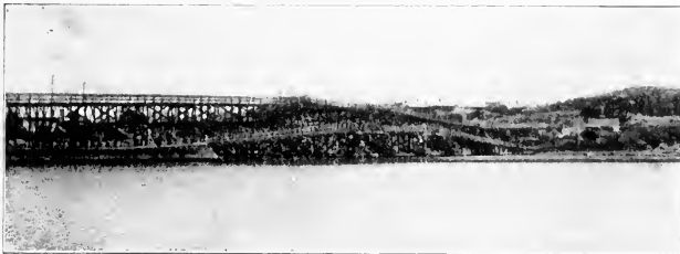
Alte Holzbrücke, bei Fremantle den Swan River überquerend.
