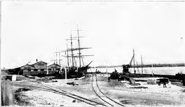
Hafen- und Kai-Anlagen von Fremantle.
