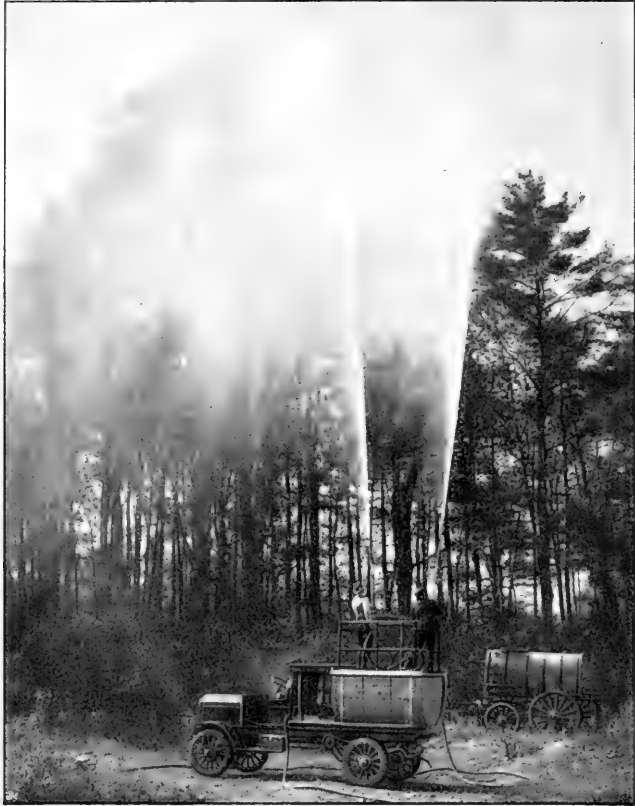
Fig. 219. Motorspritze (auf Automobil) mit zwei Schläuchen. (Phot. Fitzhenry-Guptill) Aus Escherich.
