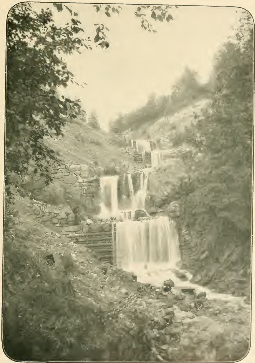
Verbauung des Fielibaches bei Beckenried (Kt. Nidwalden).
