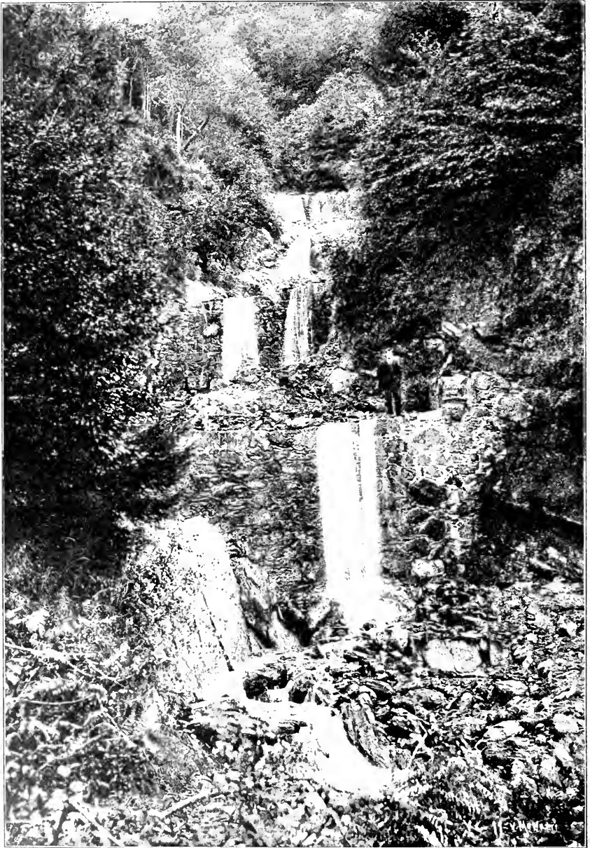
Einzugsgebiet des Cassarate im Val Colla (St. Tessin). Aufforstung und Verbau im Val Lavazè Bogno.
