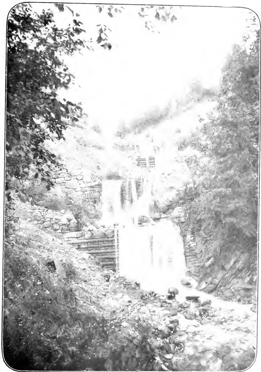
Verbauung des Fielibaches bei Beckenried (A. 1880)
