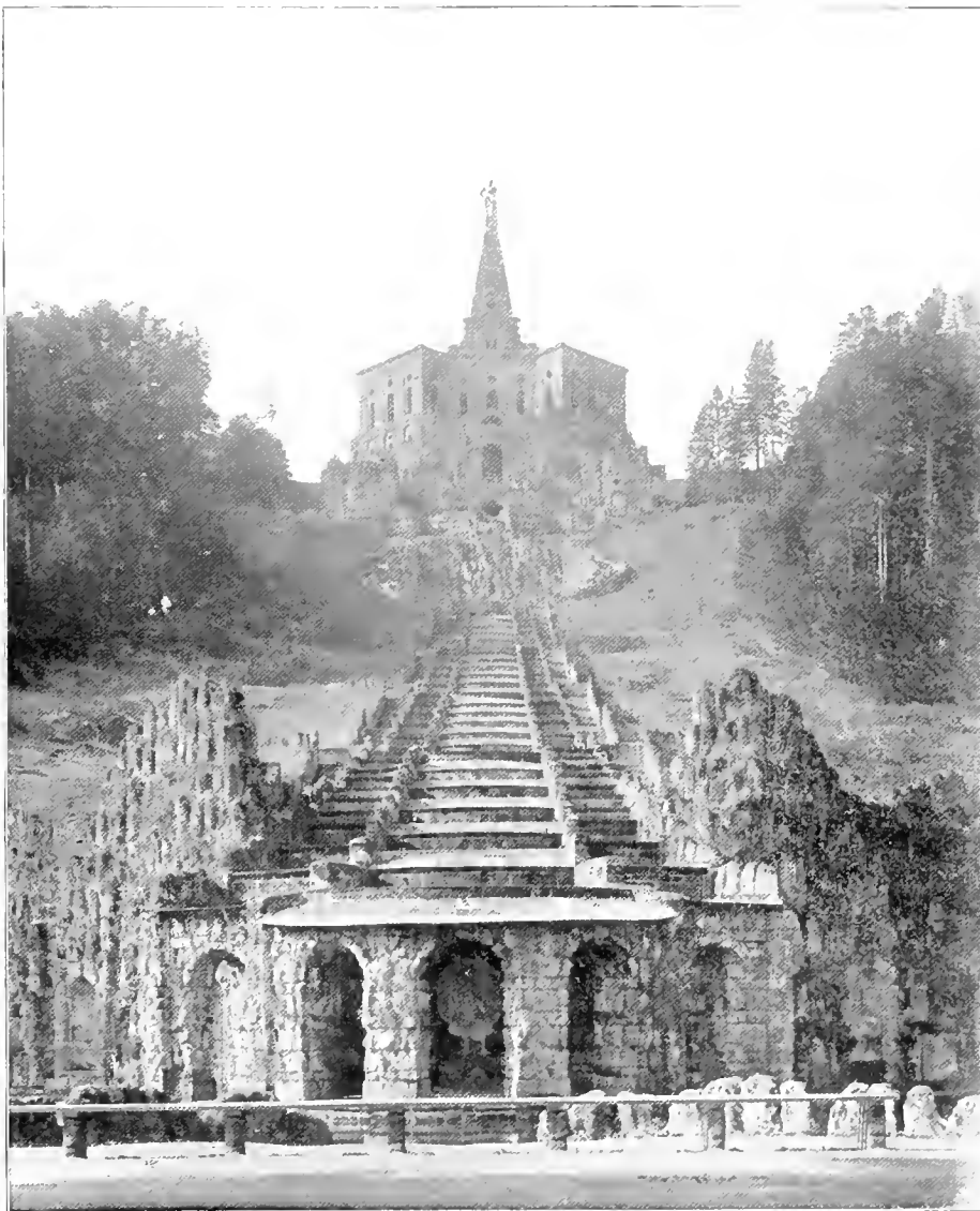
Die Kaskaden nach Abtrieb der Fichten 1904.
