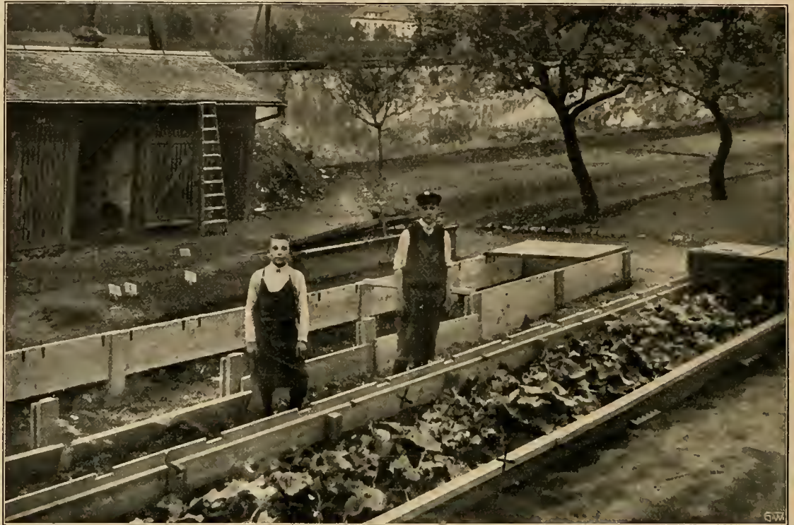
Mistbeetkasten aus Zementholz im Bau, davor Holzkasten mit Gurken (× eine thripskranke Stelle), in der gärtnerischen Versuchsstation der Stadt Mülhausen i. E. Originalaufnahme für die „Gartenwelt“.
