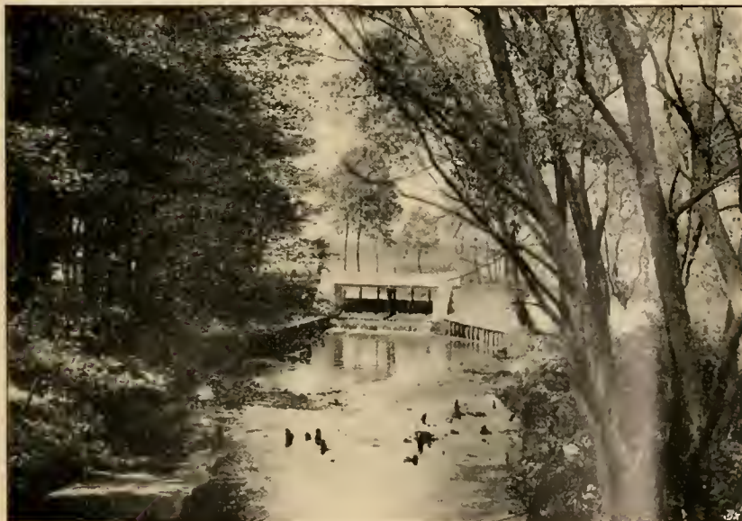
Blick von der Wehrinsel auf den Mühlgraben mit Brücke.
