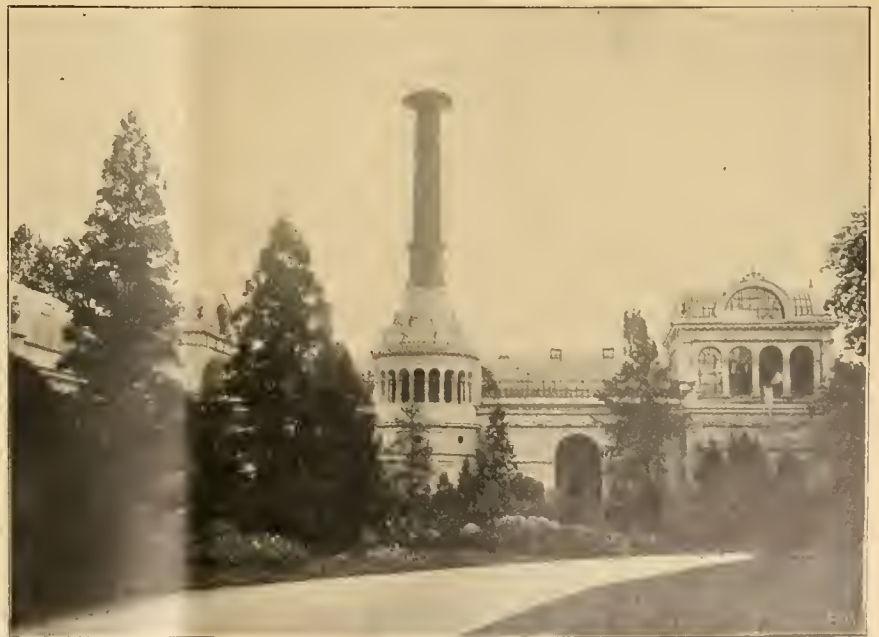
Villa Hammerschmidt. Rückseite des Palmenhauses mit dem als Treppenturm ausgebauten Schornstein der Heizungsanlage.
