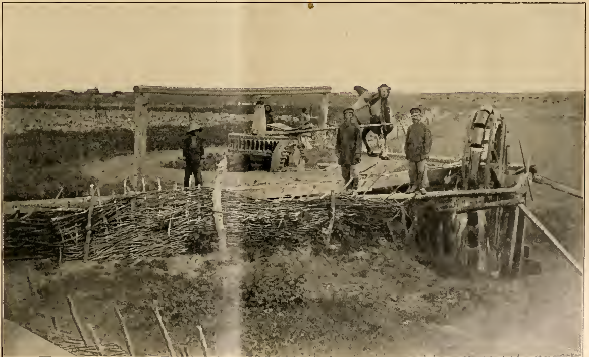
Bewässerung von Gemüsefeldern in Astrachan durch ein, von einem Kamel in Bewegung gesetztes Schöpfrad.
