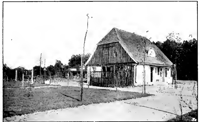
Arbeiterwohnhaus der Gesellschaft „Eigene Scholle“.
