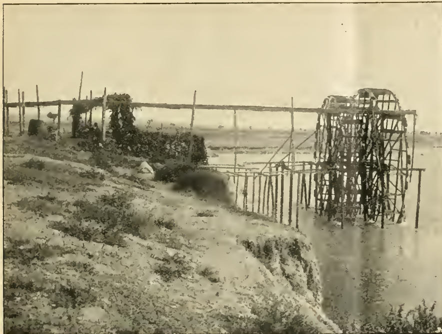
Doppelschöpfrad einer Bewässerungsanlage am Leitumfluß in Adana (cilicische Ebene, Kleinasien).
