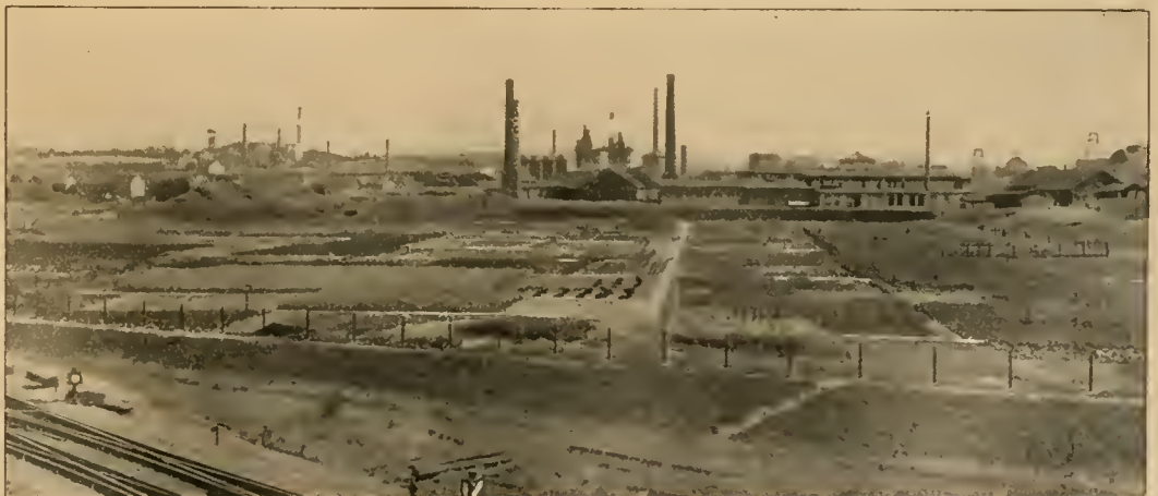
Versuche mit Kohlensäure-Düngung an gärtnerischen Kulturpflanzen. Abb. 4. Freilandanlage mit Begasungsrohren beim Horster Hochofenwerke bei Essen.
