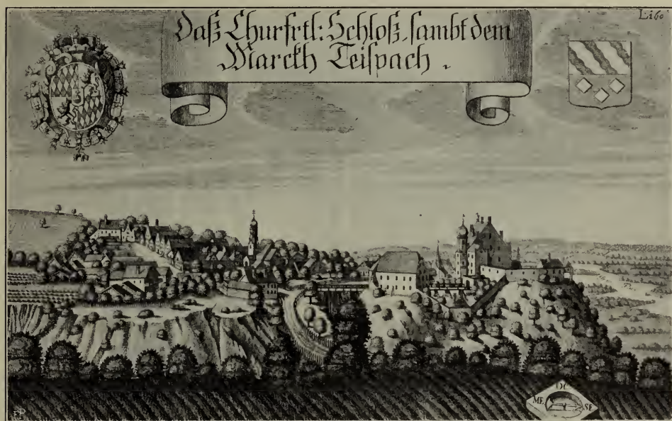
Fig. 107. Teisbach. Ansicht bei WENING, Rentamt Landshut.
