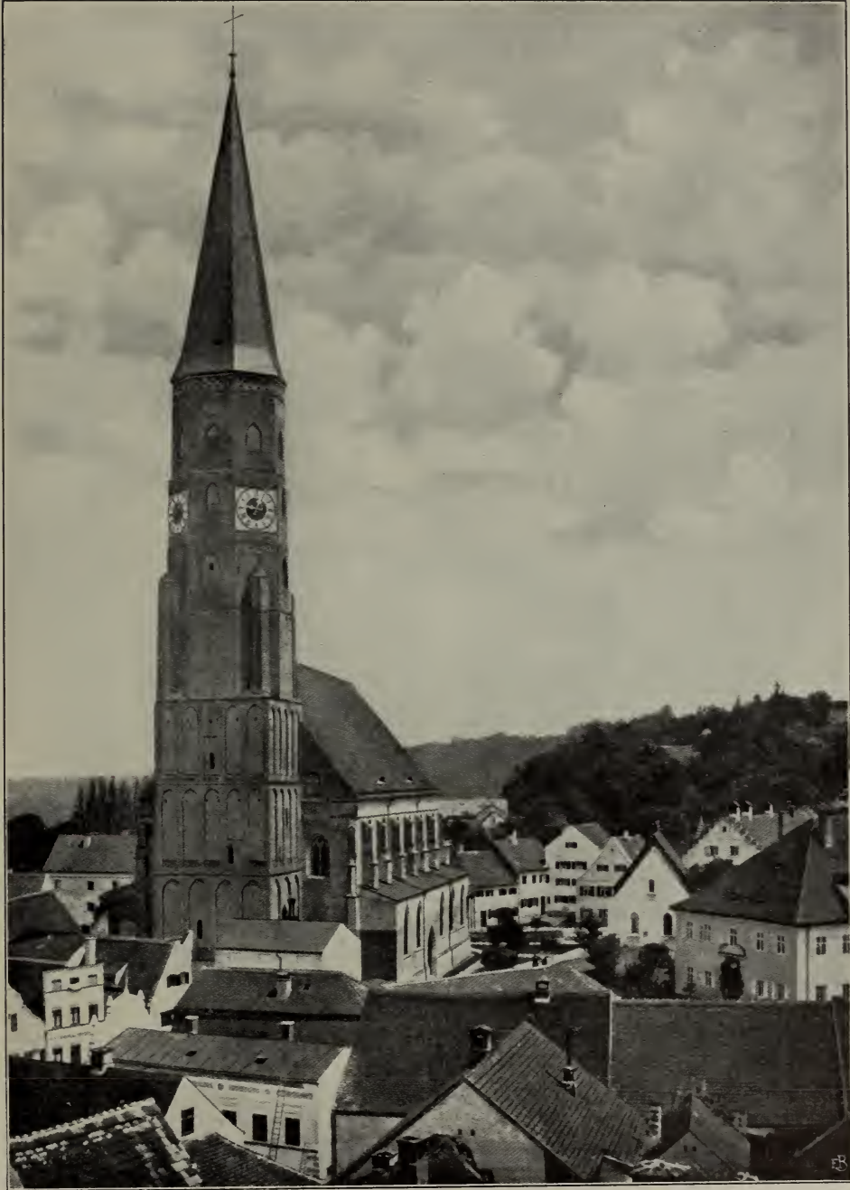
Fig. 8. Dingolfing. Ansicht der Stadtpfarrkirche von Südwesten.
