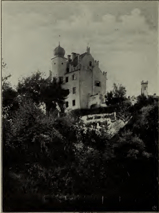
Fig. 108. Teisbach. Ansicht des Schlosses von Süden.
