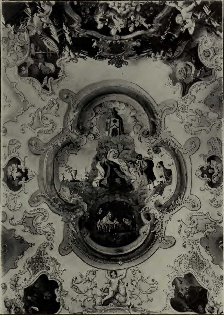
Fig. 98. Reisbach. S. Salvatorkirche. Stukturen am Chorgewölbe.
