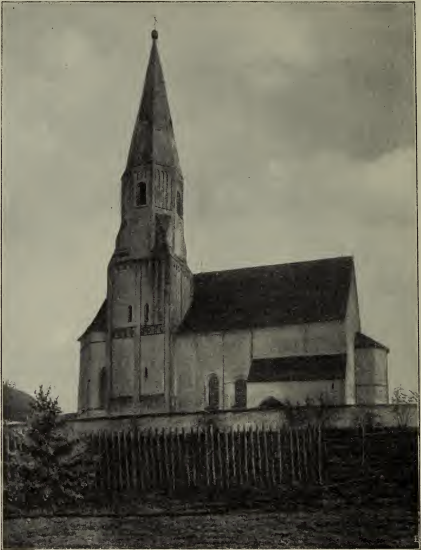
Fig. 77. Oberdingolfing. Ansicht der Kirche von Norden.
