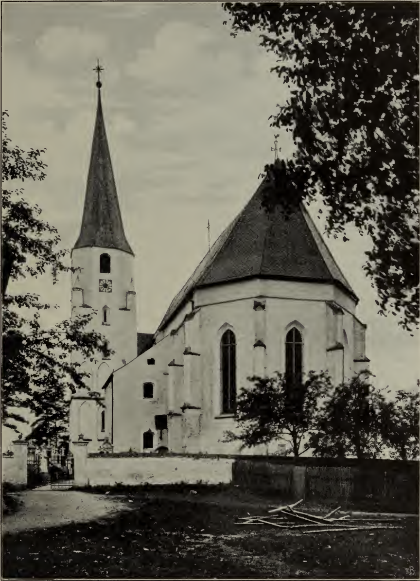
Fig. 45. Loiching. Ansicht der Pfarrkirche von Osten.
