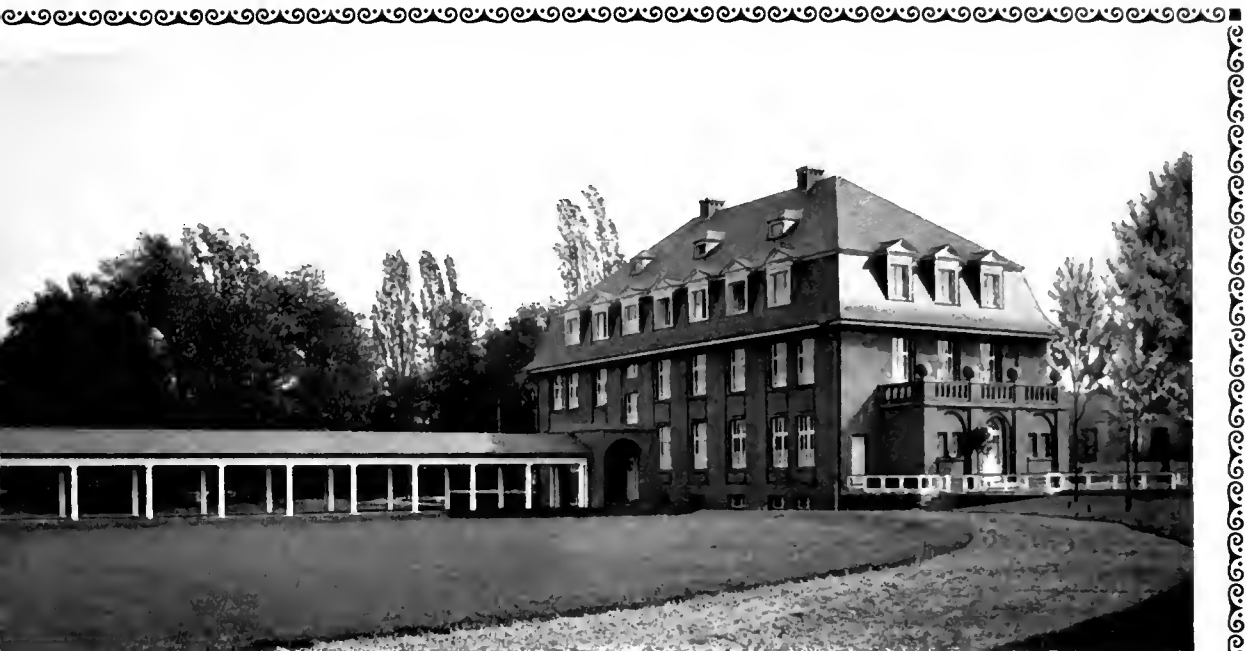
WANDELHALLE MIT ANSCHLIESZENDEN BAUTEN
