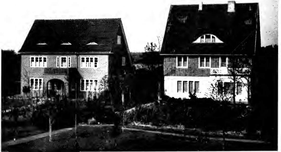
ARCH. KRUG: HAUS KRUG U. ARCH. P. MEBES ■ HAUS MILDNER IN ZEHLENDORF: STRASZEN- U. GARTENANSICHT
