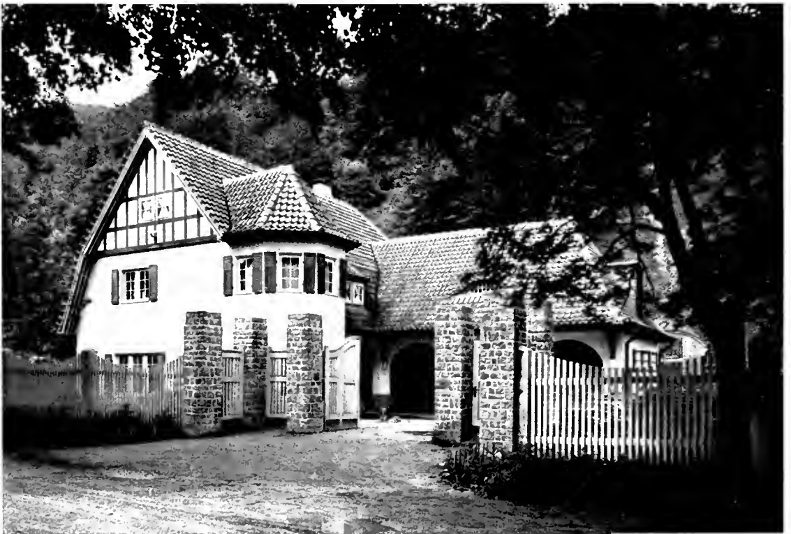
ARCH. HERMANN MUTHESIUS □ TORHAUS MIT AUTOGARAGE DER HAUSER BÜTTNER U. HARMS IN BODENWERDER
