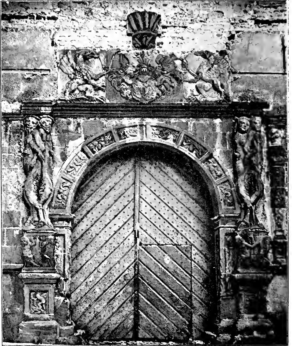
Hauptportal vom Fürstenhof vor der Restauration. Sandstein-Arbeiten.
