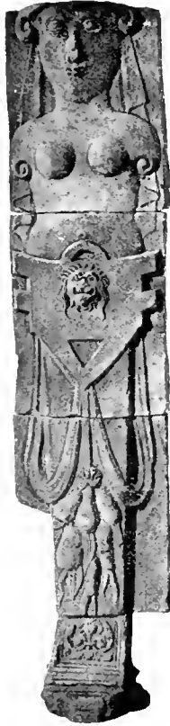
Einfassungs-Pilaster der alten Fenster. Gebrannte Formsteine.
