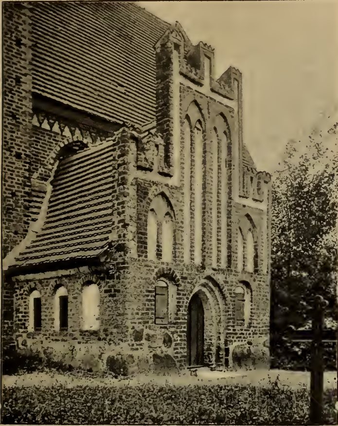
Vorhalle auf der Südseite der Kirche.
