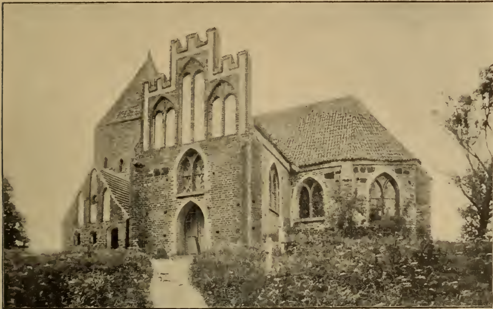
Kirche zu Westenbrügge, Südseite.
