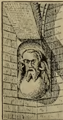
Konsolenschmuck unter den aufsteigenden Rippen der Chorgewölbe.
