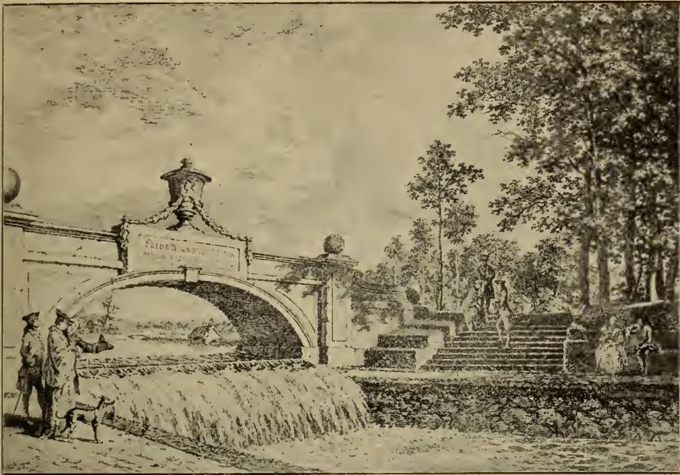
Steinerne Brücke im Schlossgarten, nach Findorff.
