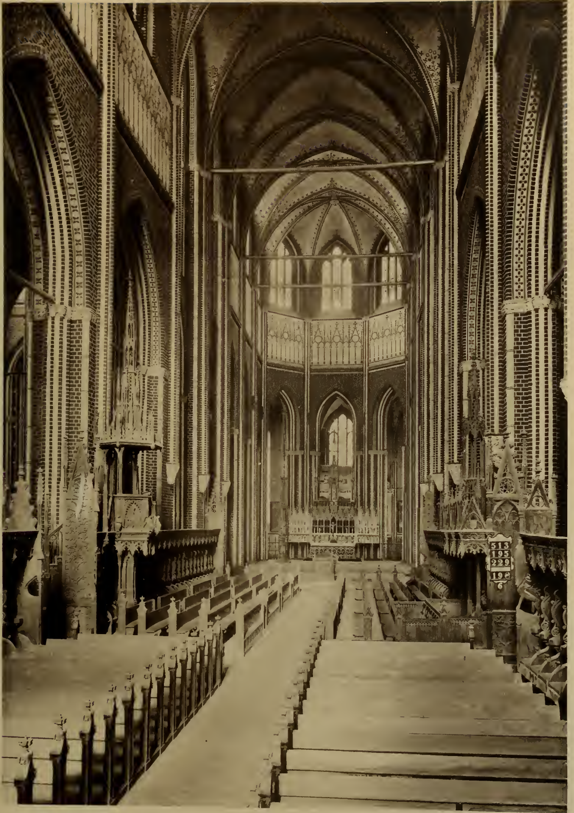
Blick aus dem Langhaus in den Chor (nach Osten).
