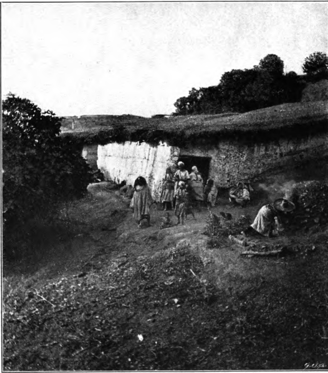
Hauseingang eines riffschen Wohnraumes, rechts der Backofen.
