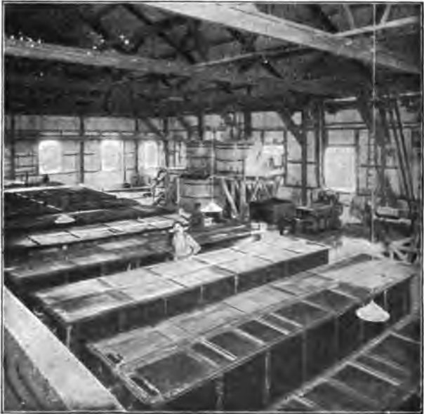
Abb. 6. Fällkästen im Fällungsgebäude.
