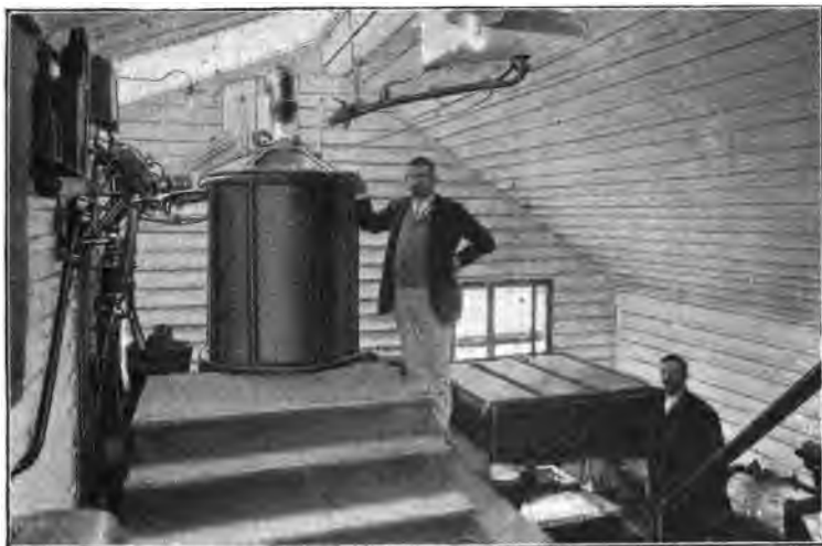
Abb. 19. Apparat zur Herstellung von Dynamit. (Aus der Aktiengesellschaft Dynamit Nobel, Wien.)
