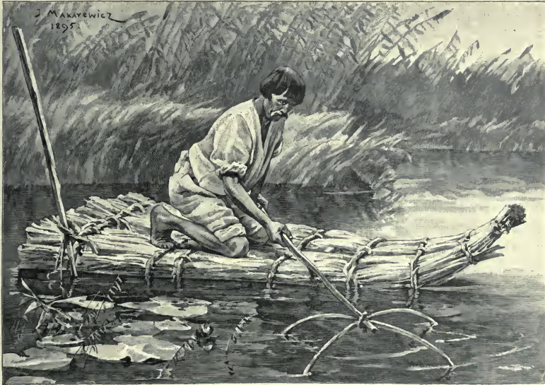
Fischfieb auf einem Rohrstoß.
