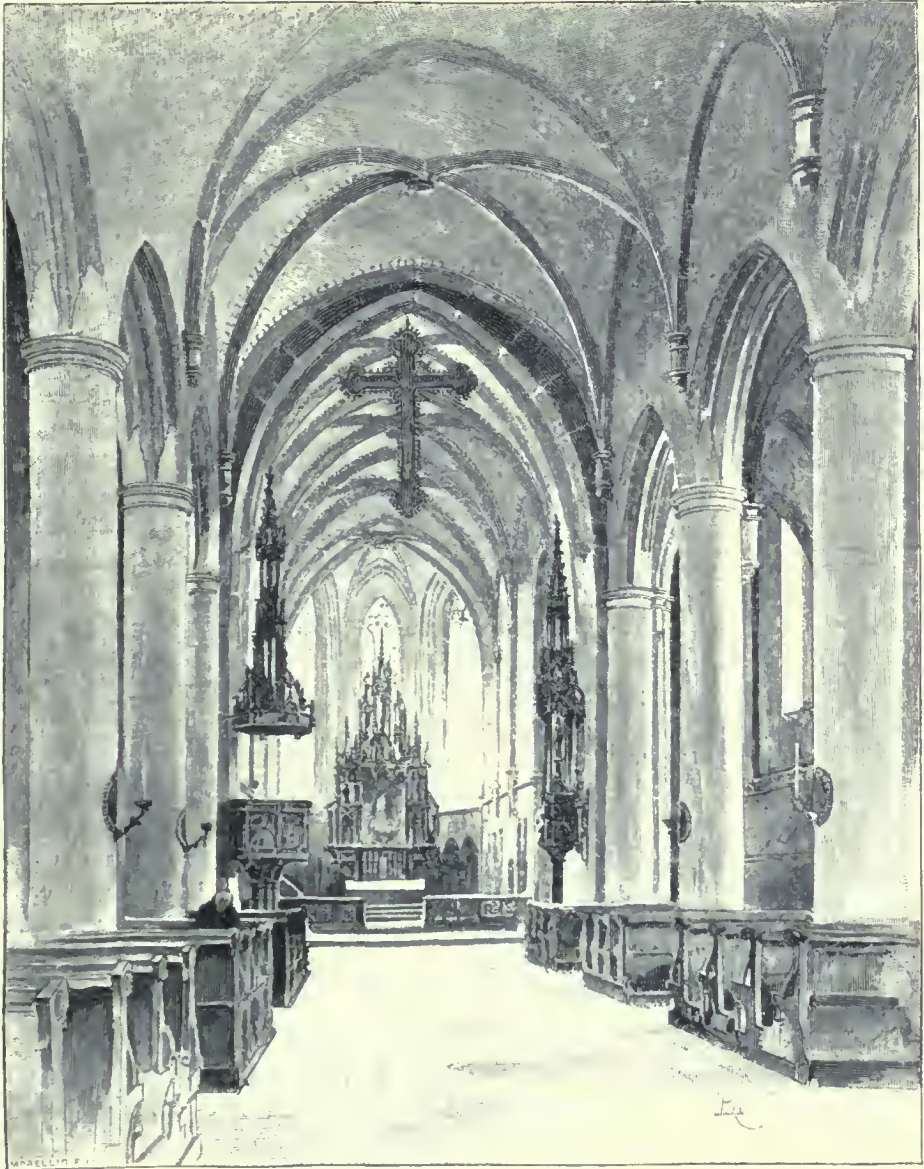
Inneres der Pfarrkirche zu St. Michael in Eidenburg.
