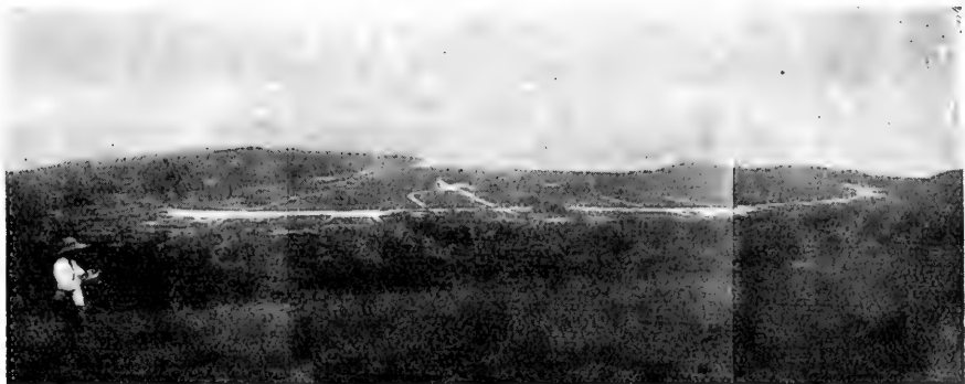
照片 4. 新筑成的消夏大圩，位于西山南部，龍渚山與明灣山之間有一公里長的石堤，石堤之外即是大湖，消夏大圩內側有 7—8 公里長的土堤，土堤之外即通向大湖的河流。接近山坡之下为果木和聚落帶。
