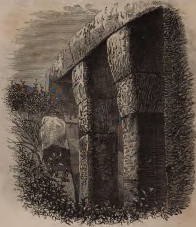
Piliers non terminés de Makhon-Wat.
