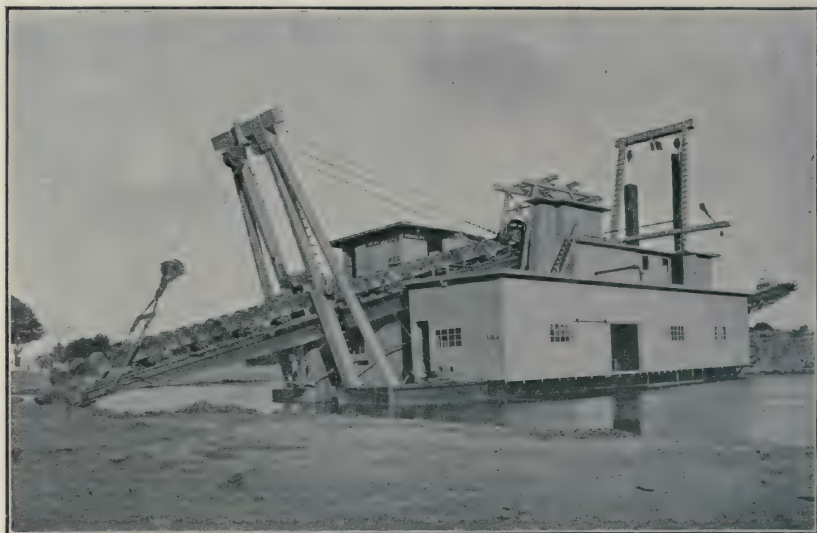
FIG. 76.—Placer Dredge.
