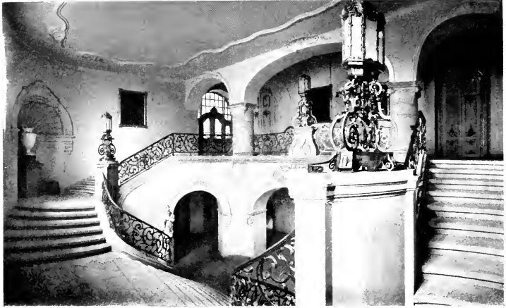
Abb. 156 Treppenhaus in der Kunstgewerbeschule von Lossow und Viehweger
