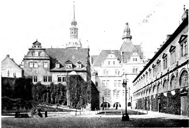
Abb. 151 Stallhof im Kgl. Schloß nach dem Umbau 1889—1901
