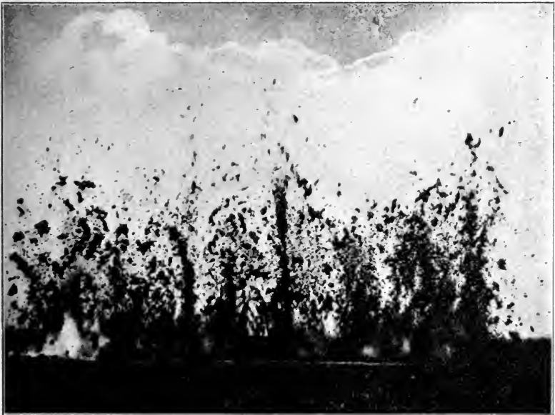
FIG. 18.—110 FOOT DITCH BLAST, ELK GROVE, SACRAMENTO CO., CALIF.
