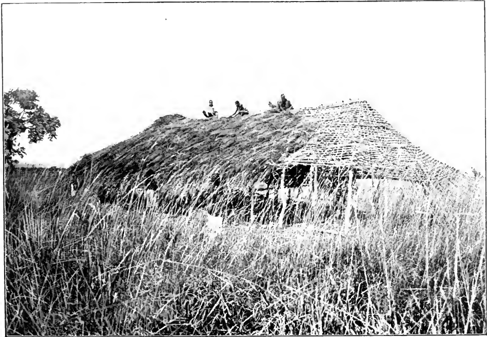
Bau unserer Wohnhütte in Umadih.
