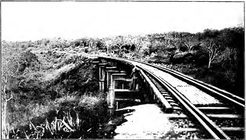
Viadukt der Uganda-Bahn. (Ziguera, Mombasa.)
