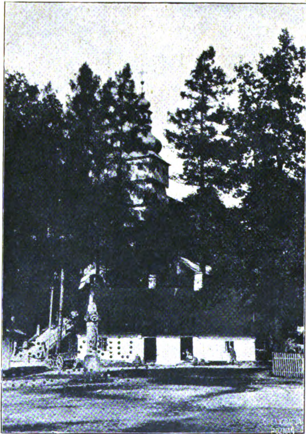
Abb. 39. Łodygowice, Holzkirche mit Aufgang.
