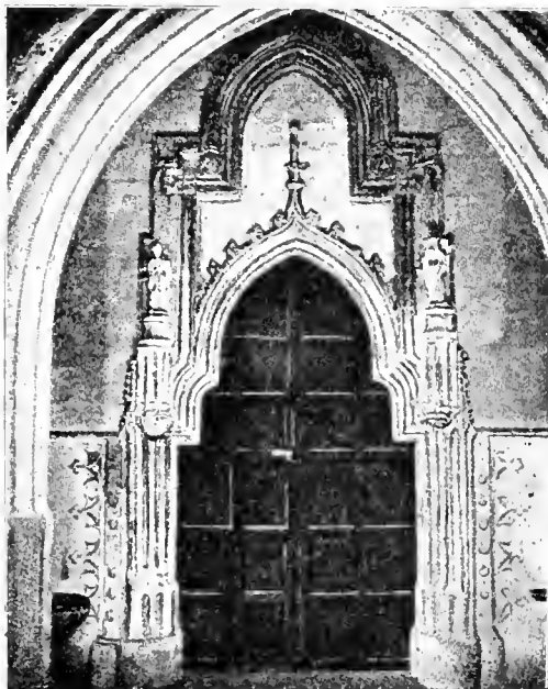
Portal kościoła św. Katarzyny.
