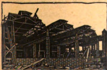
Centrale Oberspre der Allgem. Elektr.-Ges.
