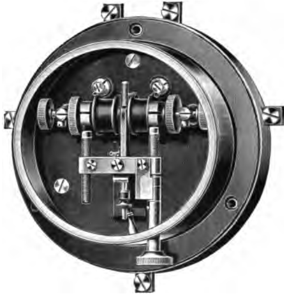
Fig. 188. Neues Relais von Siemens & Halske.
