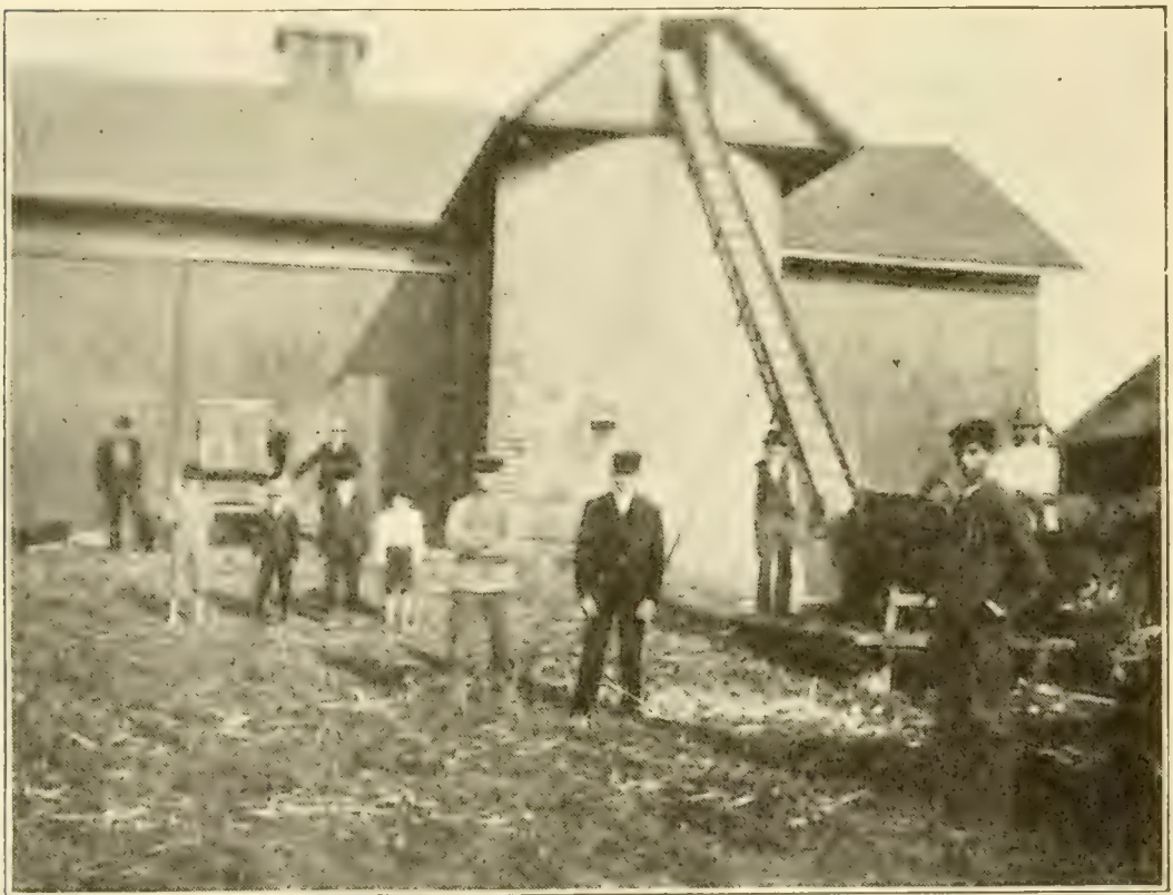
FILLING THE SILO.
