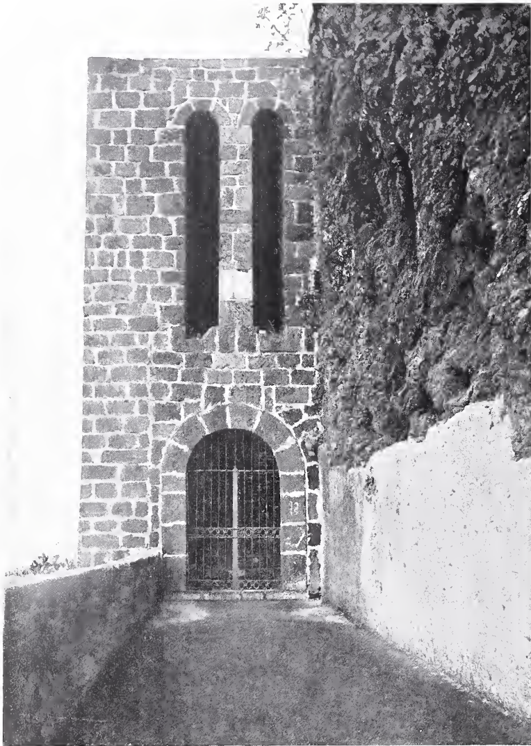
INGRESSO AL CASTELLO.
