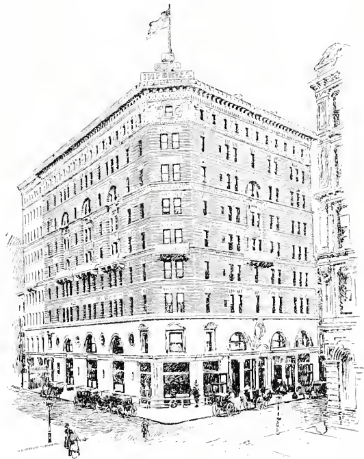
ALBERGHI MODERNI. — « HOTEL IMPERIAL » A NUOVA-YORK.
