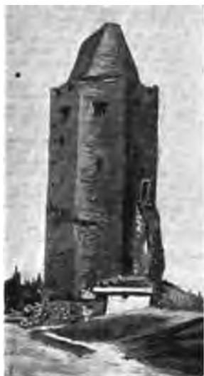
Widok baszty zamkowej w Rawie.
