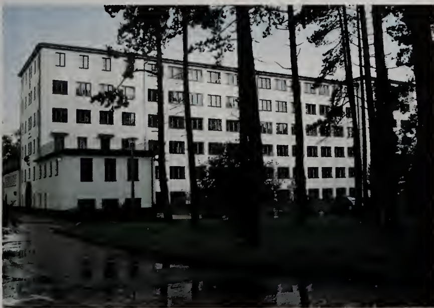
Figuur 4. Het hoofdgebouw van het voormalig herseninstituut in Berlin-Buch, nu deel van de Humboldt Universiteit. Foto: Arnold de Boer The main building of the former brain institute in Berlin-Buch, now part of the Humboldt University.
