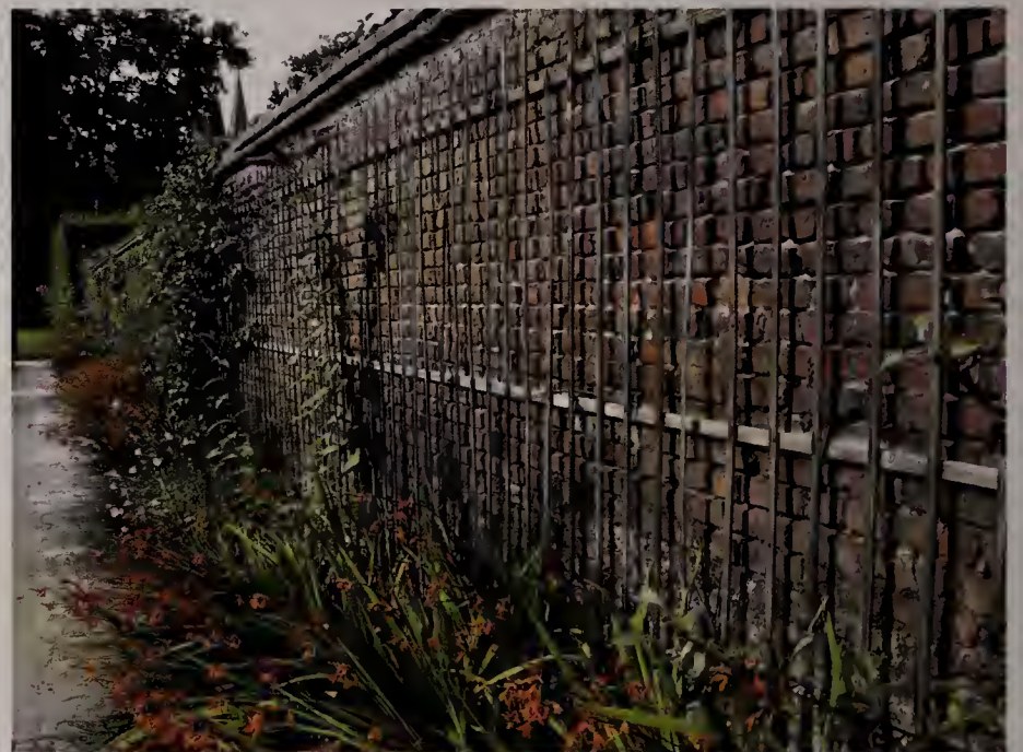
3. Deze oude schansmuur in Geldrop is gemetseld met kalkspecie en biedt nestplaats voor diverse soorten bijen en wespen.
