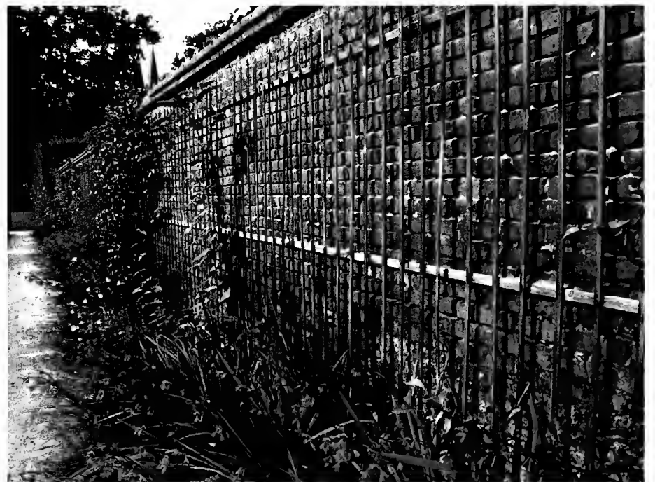
3. Deze oude schansmuur in Geldrop is gemetseld met kalkspecie en biedt nestplaats voor diverse soorten bijen en wespen.
