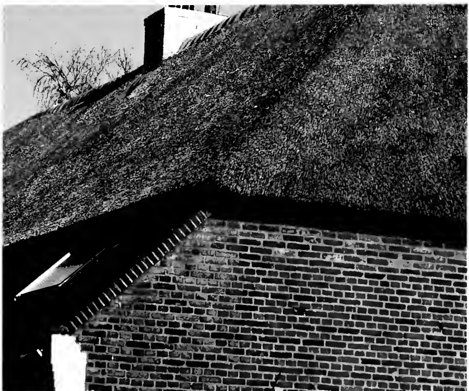
11. Een rieten dak biedt voor kleine bijen en wespen jaren lang geschikte nestplaatsen zonder dat er schade wordt aangericht. 11. A reed roof offers proper nesting sites to small bees and wasps for many years.
