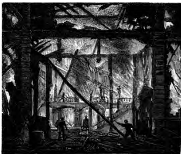
Effet d'incendie vu de la salle.
