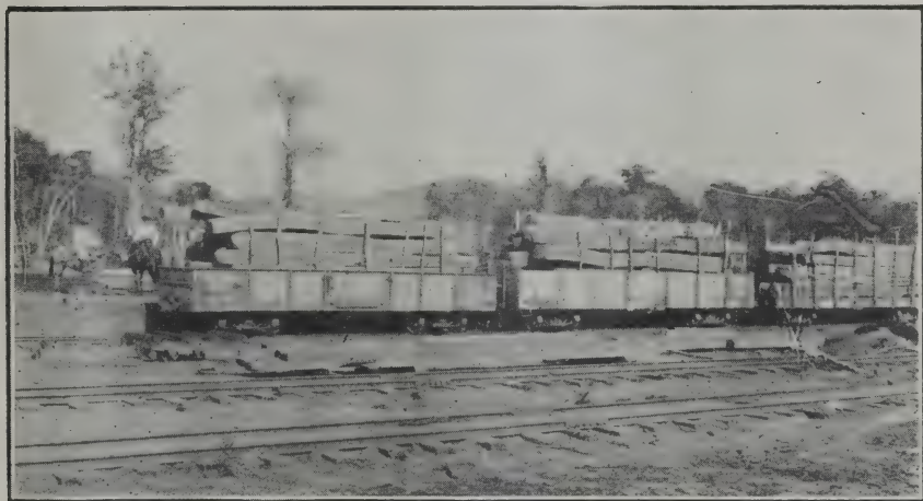
Fig. 24. — Vigas cargadas sobre vagón en la estación de Tartagal
