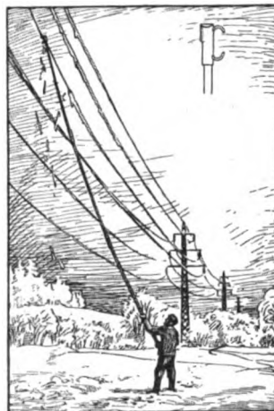
Abb. 1. Eisabschlagen an einer 30 kV-Leitung.
