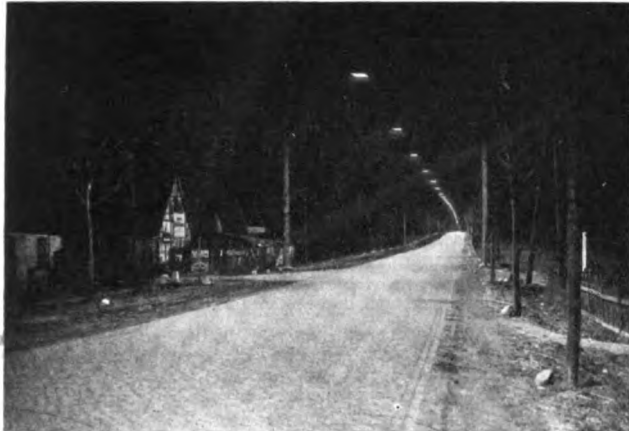
Abb. 2. Mit Natriumdampfampfen beleuchtete Versuchsstrecke bei Dallgow-Döberitz.
