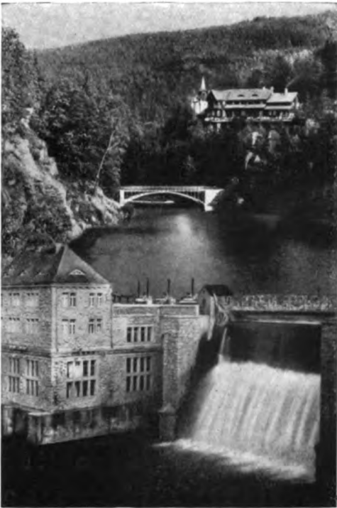
Stauanlage bei Boberröhrsdorf mit Turmsteinbaude Erbaut 1924 – 1925. Stauraum 500 000 cbm. Länge der Wehrmauer mit Turbinenanlage etwa 90 m. Gefälle 14,5 m. Im Kraftwerk: 3 Turbinen 1800 + 1100 + 600 = 3500 PS, 3 Drehstromerzeuger = 3460 kVA. Jahresleistung: 8 Millionen Kilowattstunden
