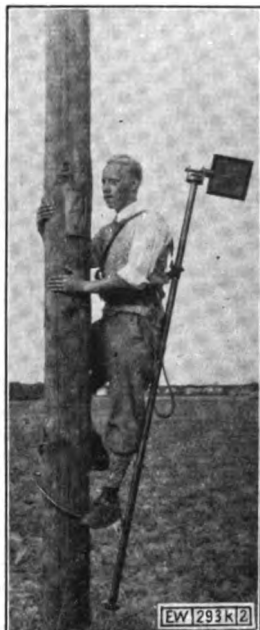
Abb. 14. Spiegelgerät zum Untersuchen von Isolatoren.
