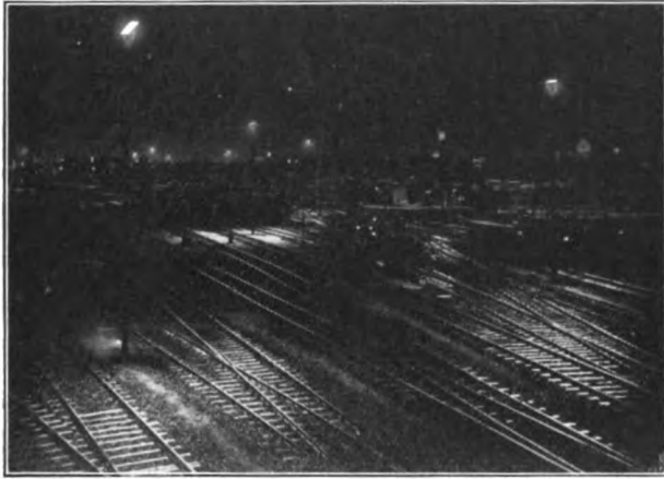
Abb. 8. Gleisfeldbeleuchtung mit Natriumdampflampen (120 W).
