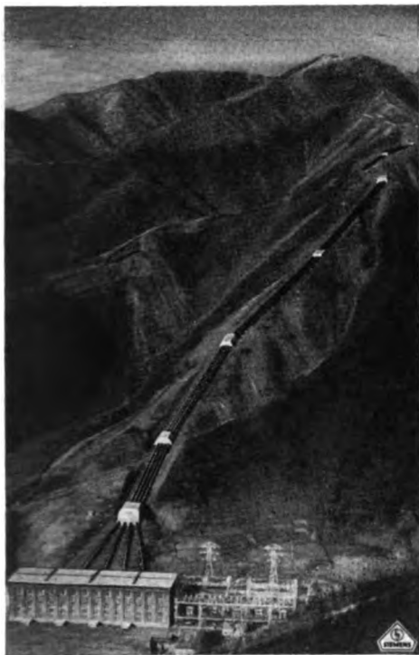
Abb. 2. Kraftwerk Shoko Nr. 1.
