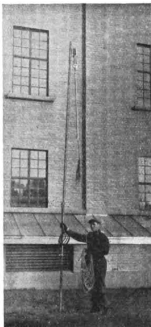
Abb. 2. Eismesser mit Bedienungstange und Zugseil.
