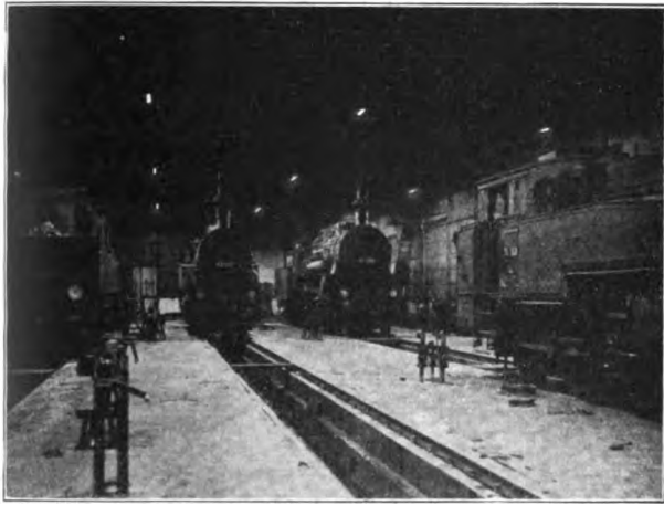
Abb. 11. Beleuchtung eines Lokomotivschuppens mit 16 Na-Lampen von je 70 W.
