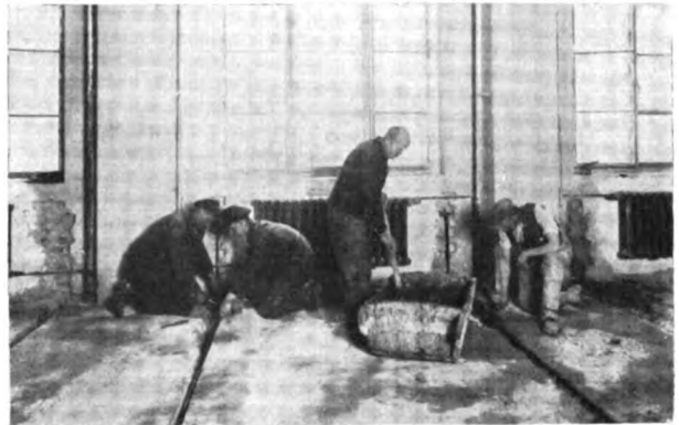
Abb. 5. Stahlrohrverlegung in vorbereiteten Rinnen.
