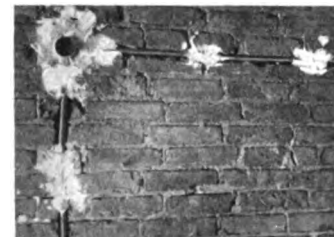
Abb. 16. Verlegung von Gummirohr unter Putz.
