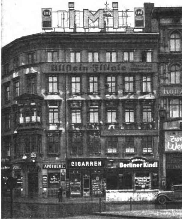
Abb. 1. Kombinierte Neon- und Glühlampen-Lichtreklame-Anlage der Firma Henkel & Cie., Berlin, Moritzplatz (Tagesaufnahme).
