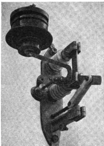
Bild 7. Probeweise eingebauter Überspannungsableiter.
