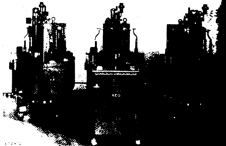
Bild 5. Gleichrichtergruppe 6000 A, 800 V der AEG, bestehend aus 3 sechsanodigen Einheiten 2000 A mit gemeinsamer Vakuumhaltung.
