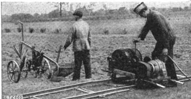
Bild 4. Eine elektrisch angetriebene Seilwinde mit zwei Kabeltrommeln für Hin- und Rückzug. Zum leichteren Umsetzen ist die Winde auf zwei Gleisstücke aufgesetzt, die bei weiterem Vorrücken umgelegt werden.
