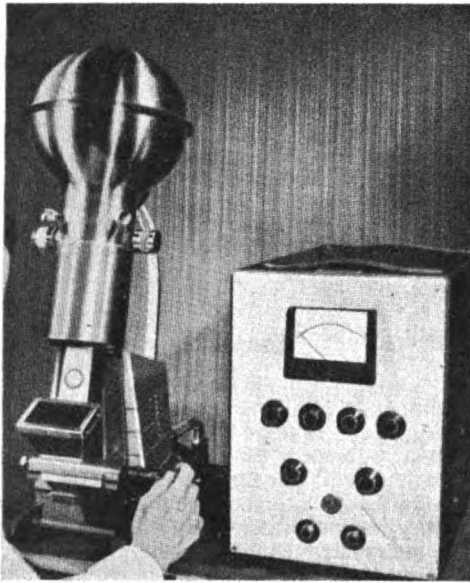
ETZ 581 Bild 5. Permanentmagnetisches Elektronenmikroskop.
