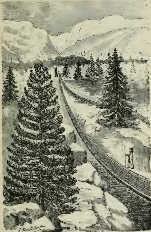
FIG. 101. — Vidange dans les hautes montagnes au moyen de wurfs ou lançoirs (d'après M. A. Frochot).
