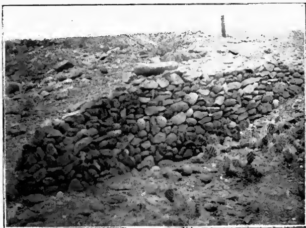
FIG 18 Muralla de sostén de una casa grande, en esta fotografía puede verse el sistema indicado de aprovechamiento de un desnivel del terreno completado con la escavación para formar esas especies de habitaciones semi-sótanos.
