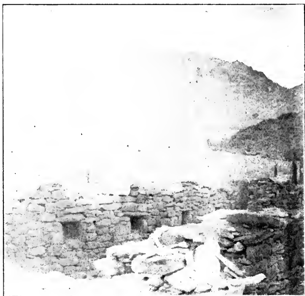
FIG. 6 RUINAS DEL ANTIGUO EDIFICIO LLAMADO LA CASA MORADA DENTRO DEL CUAL SE HIZO EL HALLAZGO DEL MATERIAL PUBLICADO EN EL SEPULCRO DE LA PAYA (MURALLA SUR)
