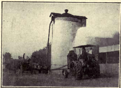
FIG. 23. — Filling the silo.
