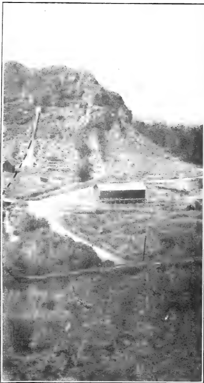
FIG. 1.—COWICHE SIPHON (No. 42), YAKIMA VALLEY CANAL CO., WASHINGTON.
