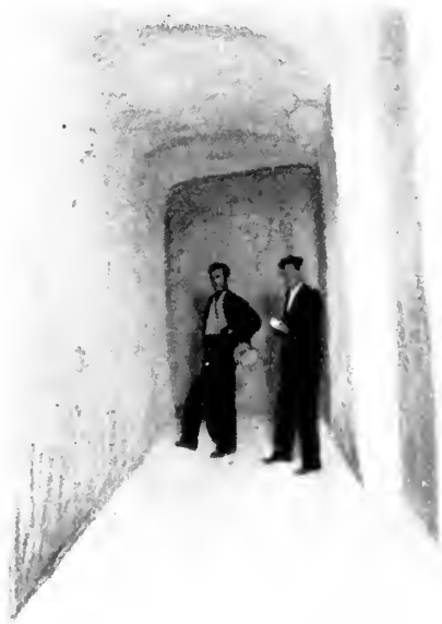
Fig. 36. ábra. Részlet a Derekaszei bánya belsejéből. A tárna egymással párhuzamosan, illetve egymásra merőlegesen futnak a hófehér kaolinban. — Detail vom Inneren der Grube von Derekaszeg. Die Stollen verlaufen parallel, resp. senkrecht zu einander in schneeweissem Kaolin.
