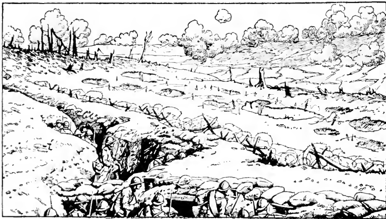
VUE DE TRANCHÉES
