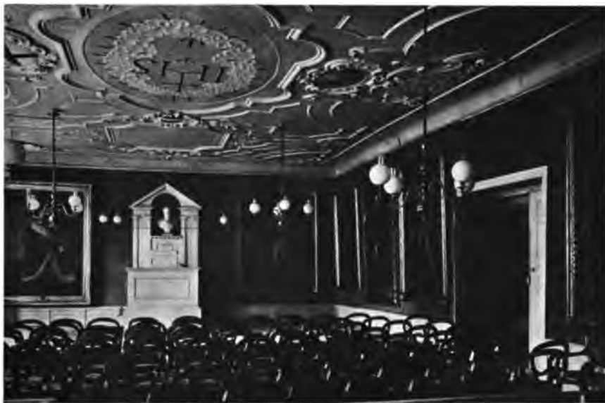
Blick in die Aula. Aufnahme von E. Ruf, Freiburg.
