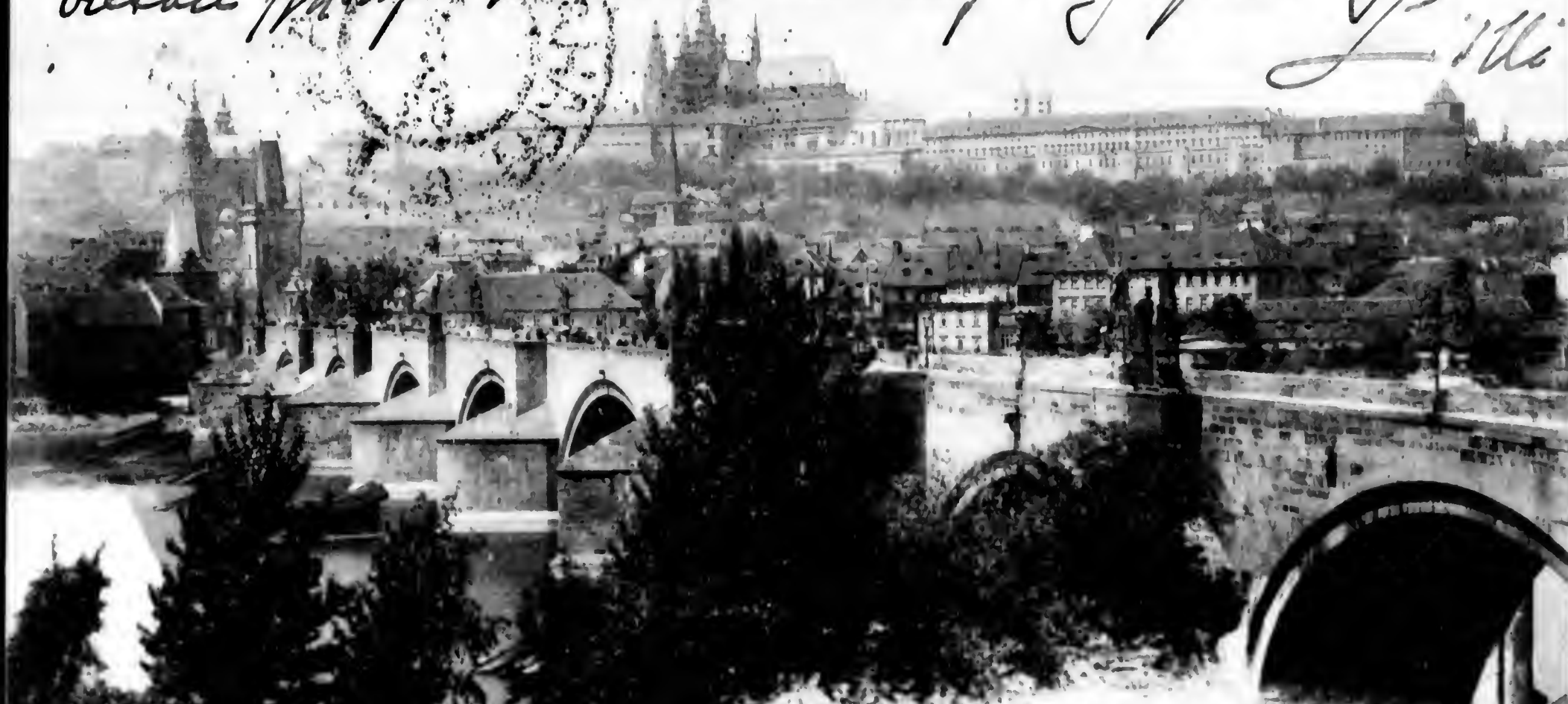
Die Karlsbrücke mit der Kleinselte. - 2.
